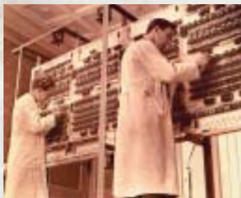
Opbygningen af DASK på Bjerregaardsvej i Valby 1957.
